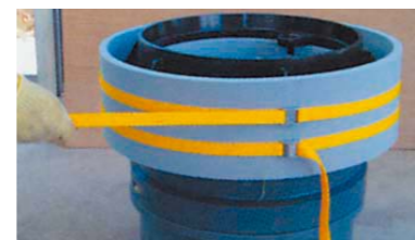
③铸铁枠外周部を外フォームを用いて閉塞します。
