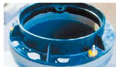
④グラウト材流し込み後約30分で硬化、埋戻しが可能となります。
