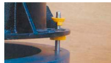
①ボルト・アタッチメントを用いて鉄蓋を所定の高さに調整します。
