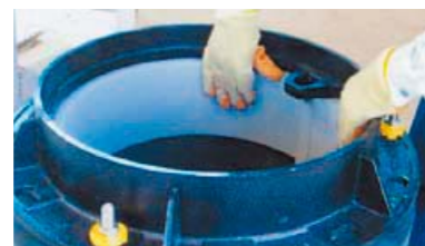
②铸铁枠内側を内フォームを用いて閉塞します。
